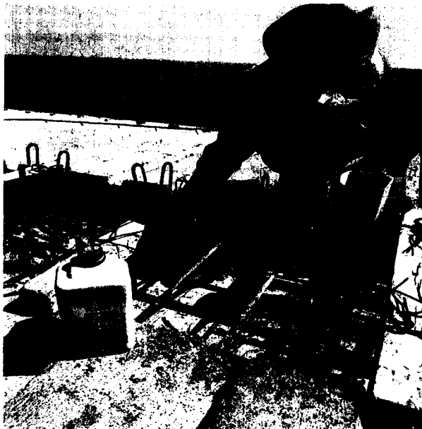
FOTO 02: Aplicación de transformador de óxido en acero
